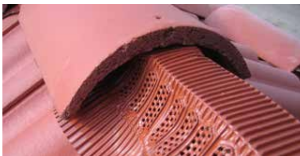
15 pav. Kraigo gaubtai tvirtinami ant jau sumontuotos kraigo ventiliacinės tarpinės.
