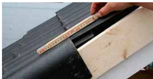
10 pav. Šoninės universalios čerpės visada turi būti viename lygyje (aukštyje) su virš jos esančia eiline čerpe
