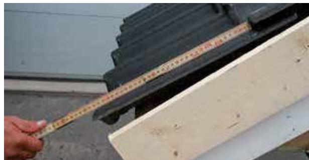
7 pav. išmatuokite apatinės eilinės čerpės matomą (neuždengtą) dalį.
