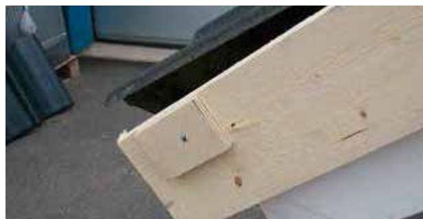
9 pav. Pritvirtinkite papildomą medinę kaladėlę prie medinės vėjalentės.
