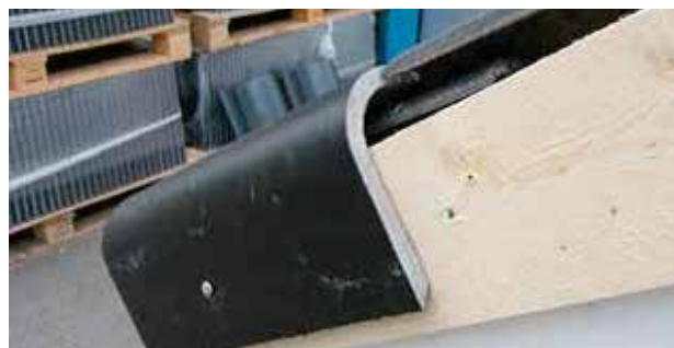
8 pav. Nupjaukite šoninės čerpės viršutinę siauresnę dalį
