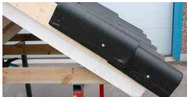
11 pav. Tvirtinant šonines universalias čerpes, pirmiausiai pragręžkite jose tvirtinimui numatytas skylės iki galo.
