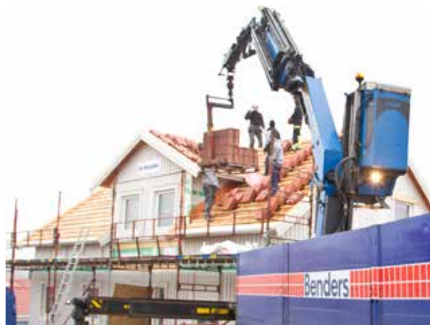
1 pav. Čerpių kėlimui ant stogo naudokite tik tam skirtą techniką su šakiniais griebtuvais.
